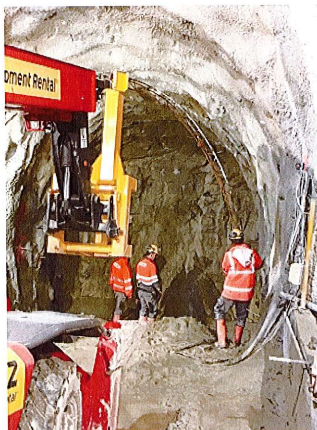
Túnel de Rio de Vila - Metro do Porto
