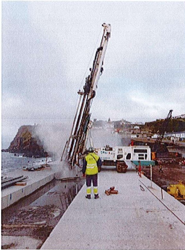
Porto das Lajes das Flores – Açores
