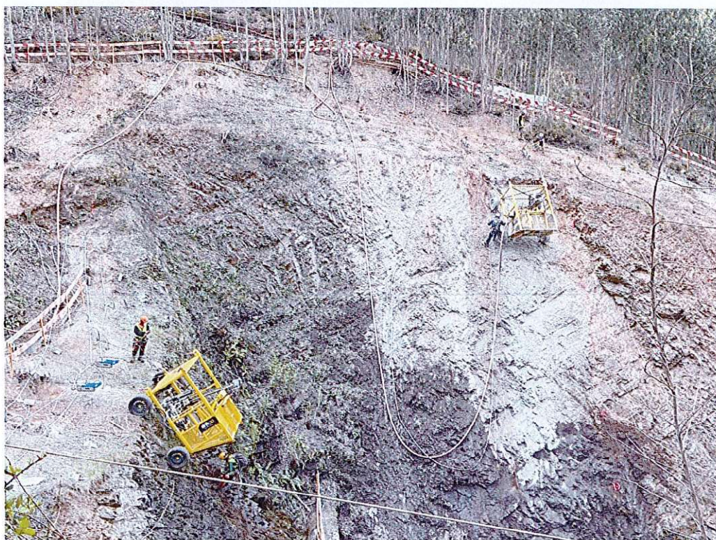
Taludes - LBA Troço Pampilhosa - St Comba Dão
