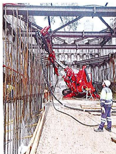
Metro do Porto - Escavação e tratamento dos tuneis a partir da Estação da Galiza
