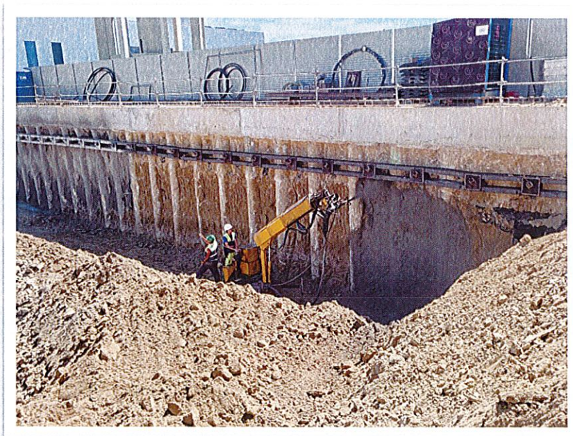
Edifício Riverline em Setúbal
