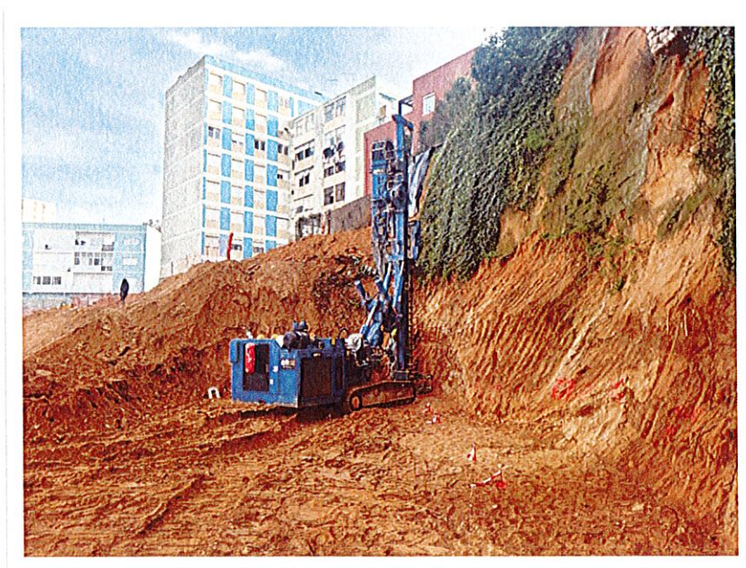
Edifício Riverline em Setúbal
