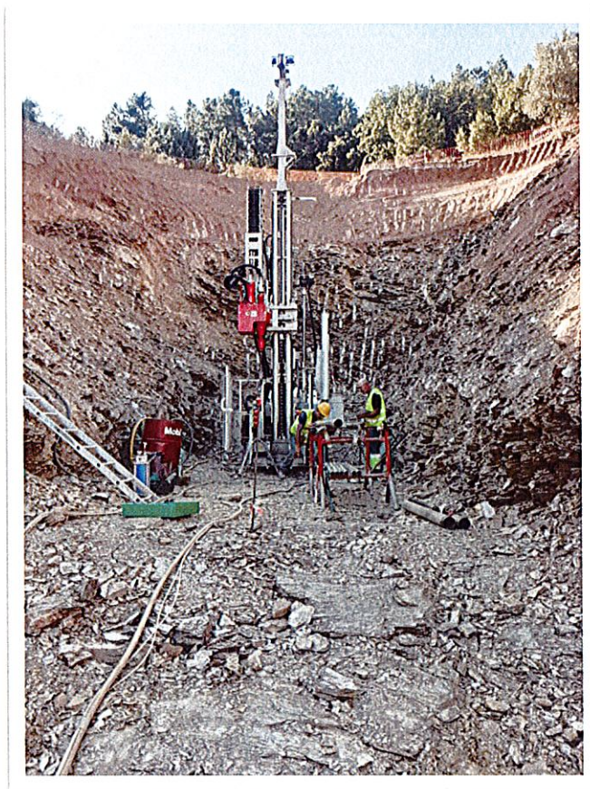
Barragem de Gebelim
